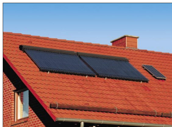
Fot. 3. Wysokosprawny kolektor rurowy najwyższej klasy VITOSOL 300-T, Viessmann
