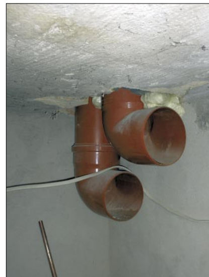
Fot. 2. Widok kanałów wentylacji nawiewno-wywiewnej w rejonie przyszłego podłączenia rekuperatora
